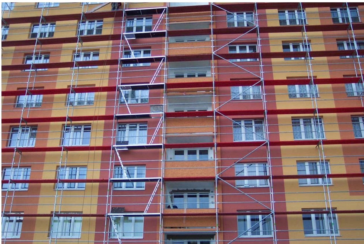
foto č. 2: výměna oken (dokončení) a zateplení obvodového pláště – severozápadní strana (DM Průhon 4800)
