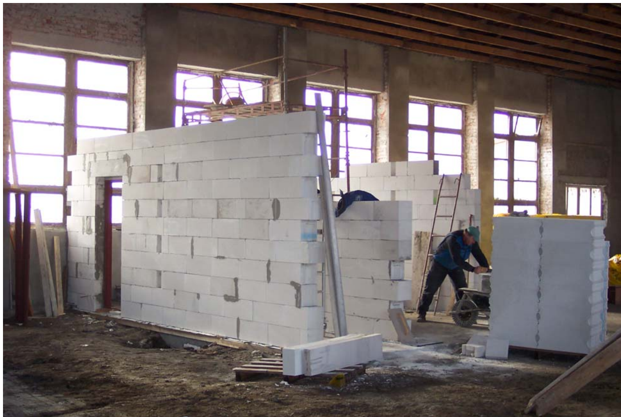
foto č. 3: výstavba sociálního zázemí – revitalizace dílen praktického vyučování oboru malíř, lakýrník a montér suchých staveb
